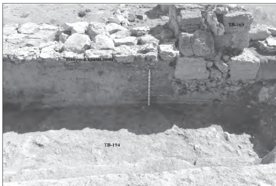
Рис. 5.2. Северная торцевая часть перегородки - стены 169 на месте стыка с северной крепостной стеной 194. Вид с севера. Раскоп III. 2016 г.
