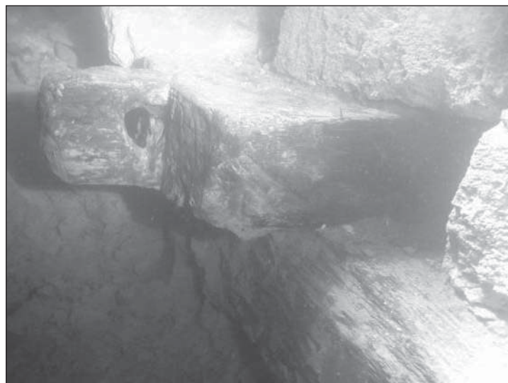
Рис. 14. Продольные и поперечные дубовые балки основания башни.
