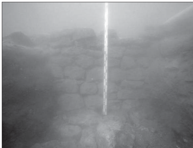
Рис. 9. Восточный фас оборонительной стены в пределах участка «Шурф №1/2011».
