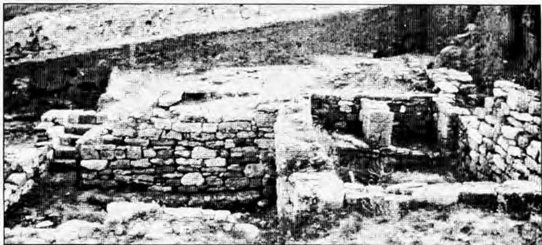
Рис. 23. Дом VI – 2. Вид с севера на подвалы №№ 395 и 410 после консервации.
