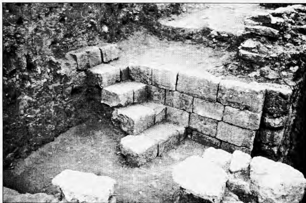
Рис. 24. Дом VI – 2. Лестница в подвал № 410. Вид с северо-востока.
