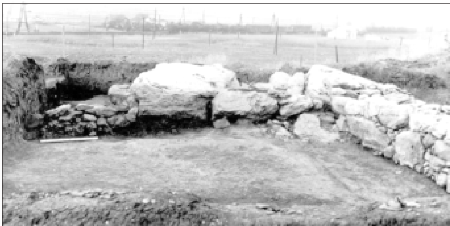
Рис. 7. Южная часть цоколя архаической оборонительной стены
