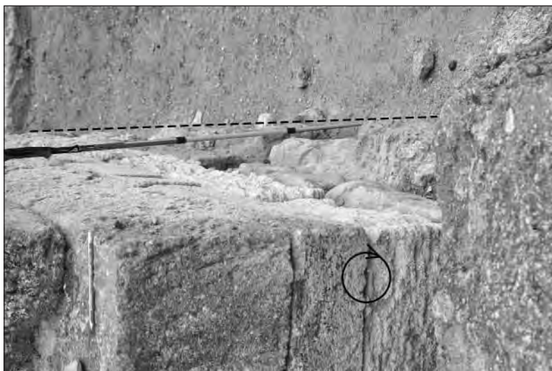
Рис. 9. Нимфей. Участок «М». Поворот верхней части стены IV в. до н.э. по часовой стрелке. Западная часть повернутой стены сместилась на север на расстояние 30 см.
