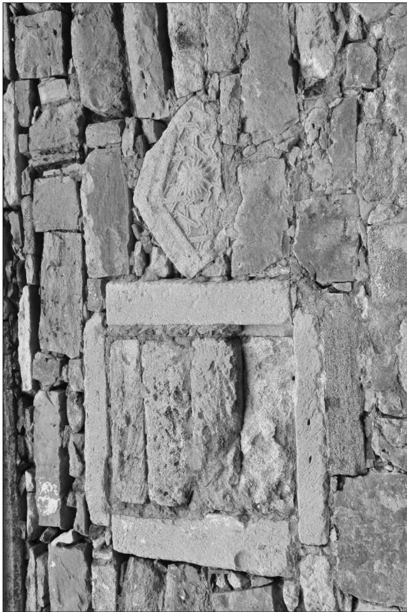
Рис. 3. Южная стена церкви. Заложенное окно I-го строительного периода в западной части южной стены церкви, а также вторичное использование в кладке фрагмента архитектурной детали с розеткой. Вид на север.
