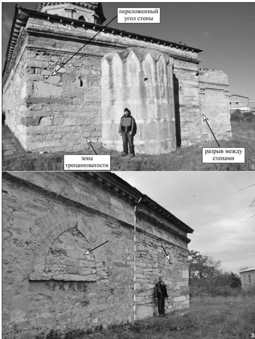
Рис. 2. Церковь монастыря Св. Георгия. 1) Восточный фасад с центральной апсидой (1-й строительный период) и пристройкой с севера, справа (2-й строительный период), вид на запад – северо-запад. 2) Южная стена церкви, кладки 1-го (слева) от 2-го (справа) строительных периодов. Белая штриховая линия показывает границу раздела. Наклонные стрелки указывают на закладку окон камнем в связи с сильной деформацией оконных арок и пространства стены над ними. Вид на северо-запад. Рост молодого человека (А.С. Ларьков), позирующего для масштаба на этом и на следующих фотографиях, – 190 см. Черной штриховой линией показана граница переложенной кладки стены. Здесь и далее наши фотографии 2015 года.
